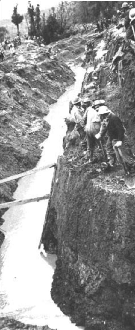
La Operación Riñihue tenía una misión clara: controlar el desborde de las aguas represadas por los deslizamientos de tierra de los cerros o "tacos", los que bloquearon completamente el desagüe natural del lago Riñihue por el río San Pedro. En promedio, diariamente el nivel de las aguas subía 50 cm. Cada metro de crecida, correspondía a 20 millones de m<sup>3</sup>.
