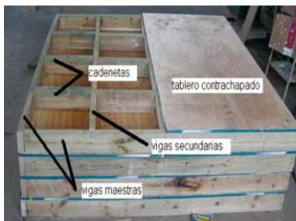
Figura 2. Estructura de piso, compuesta de vigas de 2 x 6'' impregnadas con sales CCA y contrachapados estructurales de 18 mm
